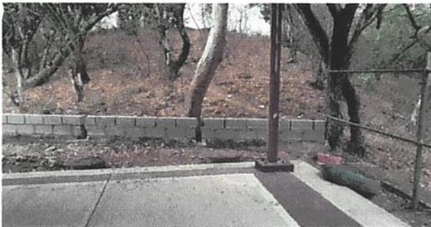
Foto 5: Levantado de hiladas de block
