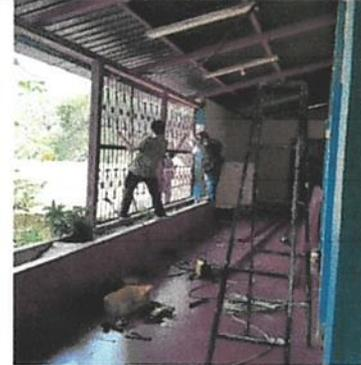
Foto 4: Instalación de balcones
